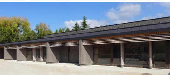
L'école est conçue selon les principes de l'architecture bioclimatique : plan compact, façade nord fermée, baies au sud équipées de protections solaires (auvent, lames brise-soleil en bois).
